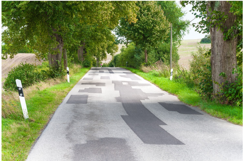
Sanierung statt Neubau zu Lasten der Anwohner
