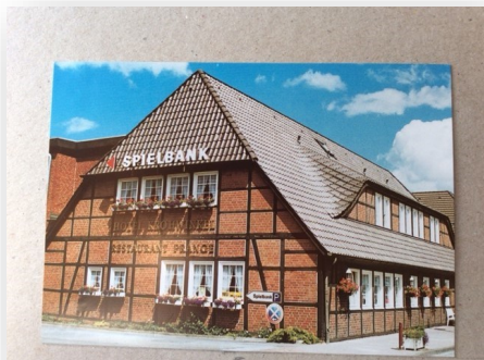
Saniertes Haus Krohwinkel nach dem Brand von 1978
