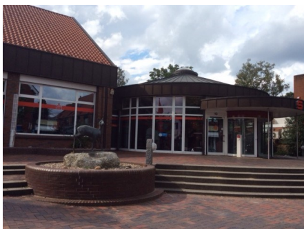
Sparkasse Harburg-Buxtehude nach Umbau 1996
