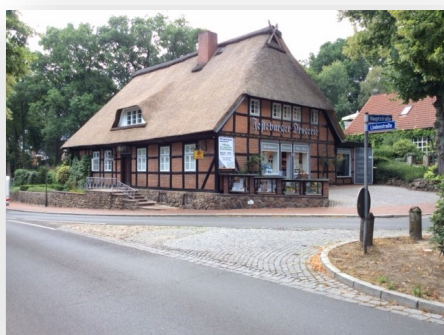
Drogerie in Jesteburg, Sanierung 1965
