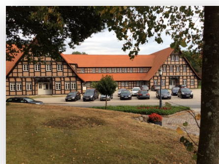
Dorfkrug Hanstedt, nach Brand in 2014 teilsaniert
