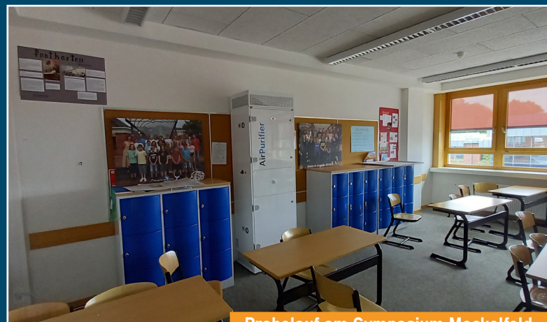
Probelauf am Gymnasium Meckelfeld
